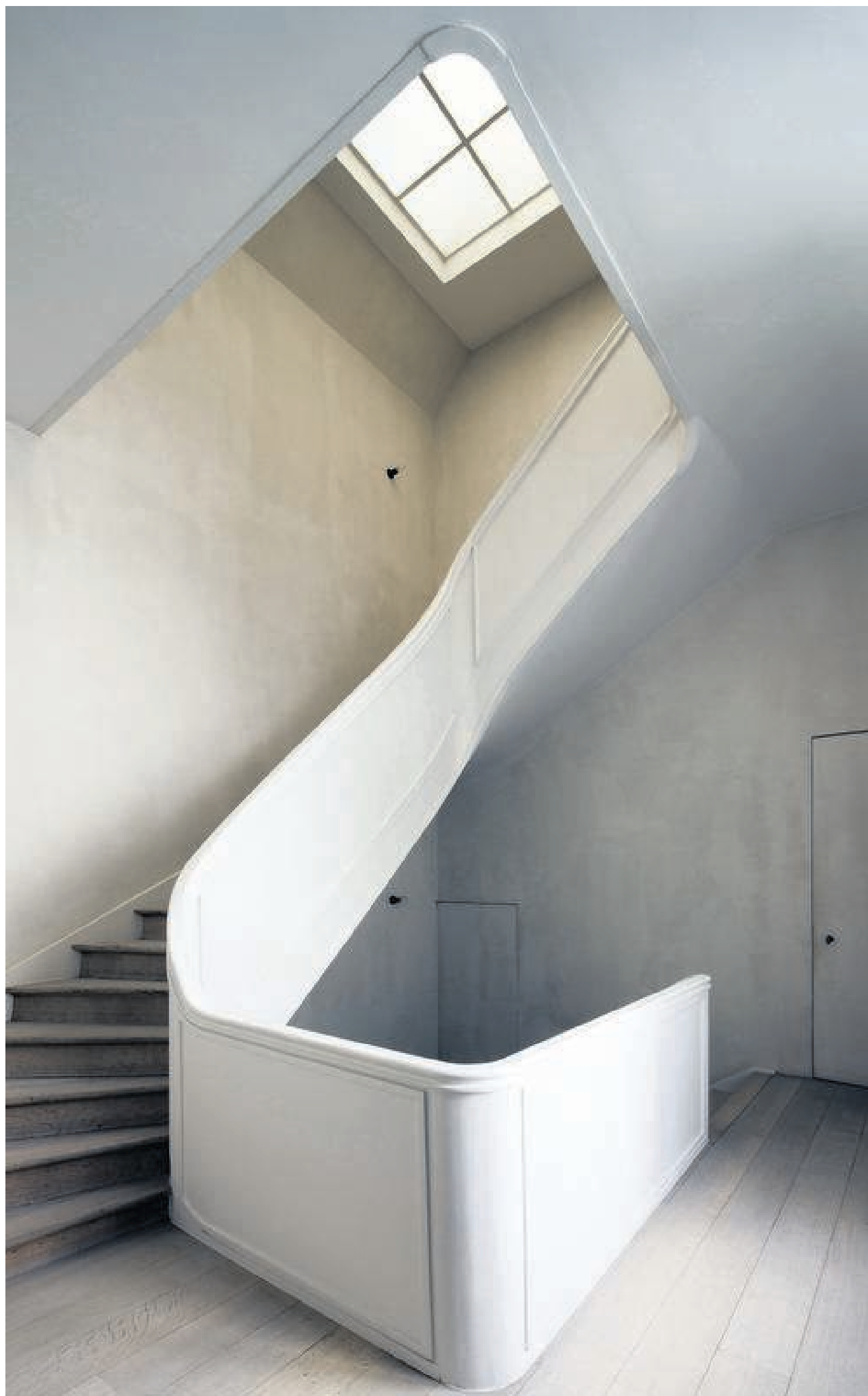
Das Treppenhaus durfte bleiben, hinzu kam das Oberlicht. Die Wände sind mit Schlamm gestrichen und scheinen zu atmen
